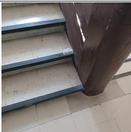
Photo n° N_A025 Localisation : ESCALIER NORD - Escalier R+2-R+2 1/2 Ouvrage : 5 - Planchers et planchers techniques - Revêtements de sols Partie d'ouvrage : Dalle de sol Description : Dalles de sol + Colle + ragréage ( Marche )
