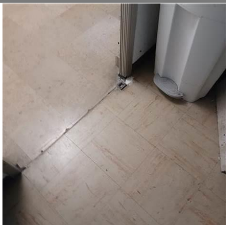
Photo n° N_A015 Localisation : ESCALIER NORD - Hall RDC Ouvrage : 5 - Planchers et planchers techniques - Revêtements de sols Partie d'ouvrage : Dalle de sol Description : Dalles de sol + Colle + ragréage
