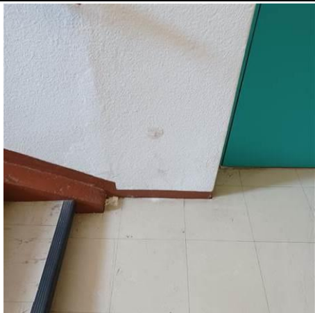
Photo n° N_A009 Localisation : ESCALIER SUD - Palier R+2 Ouvrage : 3 - Parois verticales intérieures - Murs et cloisons maçonnés Partie d'ouvrage : Enduit à base de plâtre lissé ou taloché Description : Enduit mur béton
