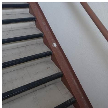
Photo n° N_A038 Localisation : ESCALIER SUD - Escalier RDC-R+1 Ouvrage : 3 - Parois verticales intérieures - Cloisons sèches (assemblées, préfabriquées) Partie d'ouvrage : Enduits à base de plâtre ou ciment projetés, lissés ou talochés Description : Enduits sur limon + peinture
