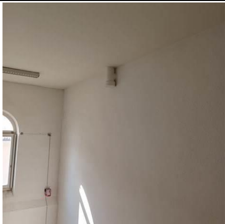
Photo n° N_A029 Localisation : ESCALIER SUD - Palier R+3 Ouvrage : 6 - Conduits et accessoires intérieurs - Conduits de fluides (air, eau, vapeur, fumée, échappement, autres fluides) Partie d'ouvrage : Conduit en fibres-ciment Description : Manchon en fibres-ciment
