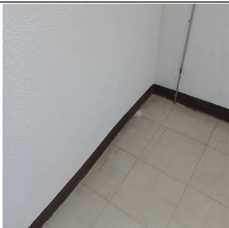
Photo n° N_A019 Localisation : ESCALIER NORD - Palier 1/2 Ouvrage : 5 - Planchers et planchers techniques - Revêtements de sols Partie d'ouvrage : Dalle de sol Description : Dalles de sol + Colle + ragréage
