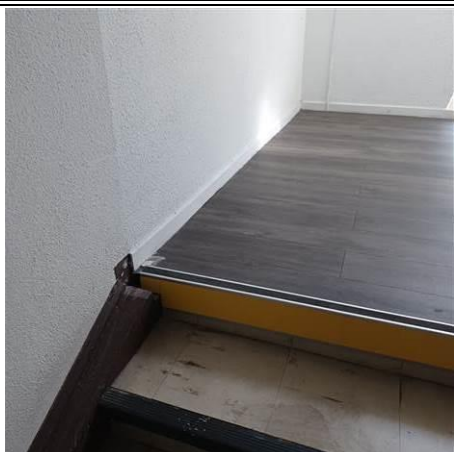
Photo n° N_A023 Localisation : ESCALIER NORD - Palier 2 1/2 Ouvrage : 5 - Planchers et planchers techniques - Revêtements de sols Partie d'ouvrage : Sous-couche (carton, feutre, ...) de revêtement souple Description : Lino + colle + ragréage
