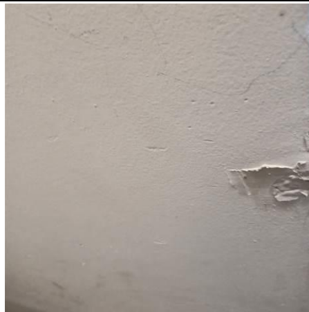
Photo n° N_A014 Localisation : ESCALIER SUD - Escalier R+1-R+2 Ouvrage : 4 - Plafonds et faux plafonds - Plafonds Partie d'ouvrage : Bandes calicot Description : Enduit + calicot plafond sous face
