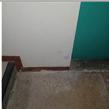
Photo n° N_A032 Localisation : ESCALIER SUD - Escalier RDC-R+1 Ouvrage : 3 - Parois verticales intérieures - Murs et cloisons maçonnés Partie d'ouvrage : Enduit à base de plâtre lissé ou taloché Description : Enduit mur béton
