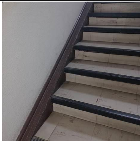
Photo n° N_A030 Localisation : ESCALIER NORD - Escalier RDC-R+1 Ouvrage : 3 - Parois verticales intérieures - Revêtements de murs, poteaux, cloisons, gaines, coffres Partie d'ouvrage : Peinture décorative (pailletées, gouttelettes, ...) Description : Peinture sur limon bois
