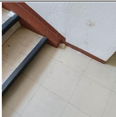
Photo n° N_A008 Localisation : ESCALIER SUD - Palier R+2 Ouvrage : 5 - Planchers et planchers techniques - Revêtements de sols Partie d'ouvrage : Dalle de sol Description : Dalles de sol + Colle + ragréage
