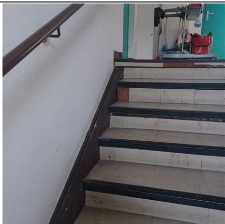
Photo n° N_A031 Localisation : ESCALIER NORD - Escalier R+1-R+2 Ouvrage : 3 - Parois verticales intérieures - Revêtements de murs, poteaux, cloisons, gaines, coffres Partie d'ouvrage : Peinture décorative (pailletées, gouttelettes, ...) Description : Peinture sur limon bois
