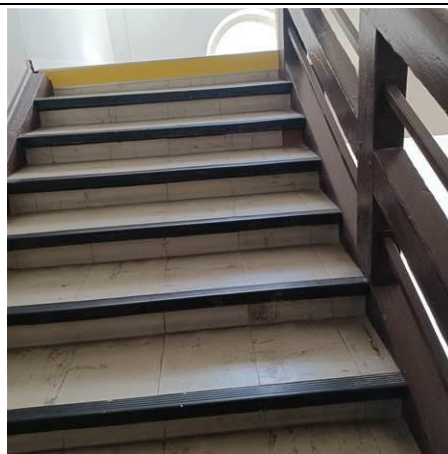
Photo n° N_A026 Localisation : ESCALIER NORD - Escalier R+2-R+2 1/2 Ouvrage : 5 - Planchers et planchers techniques - Revêtements de sols Partie d'ouvrage : Dalle de sol Description : Dalles de sol + Colle + ragréage ( Contre - marche )
