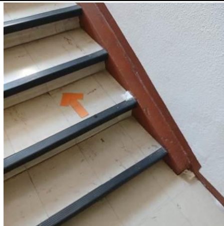
Photo n° N_A006 Localisation : ESCALIER SUD - Escalier R+2-R+3 Ouvrage : 5 - Planchers et planchers techniques - Revêtements de sols Partie d'ouvrage : Dalle de sol Description : Dalles de sol + Colle + ragréage ( Marche )
