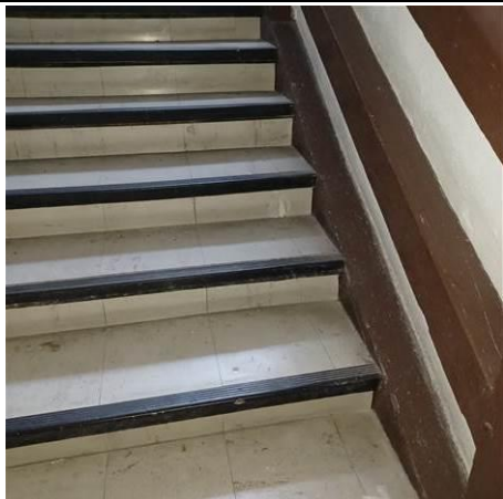
Photo n° N_A017 Localisation : ESCALIER NORD - Escalier RDC-R+1 Ouvrage : 5 - Planchers et planchers techniques - Revêtements de sols Partie d'ouvrage : Dalle de sol Description : Dalles de sol + Colle + ragréage ( contre - marche )
