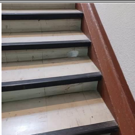
Photo n° N_A003 Localisation : ESCALIER SUD - Escalier RDC-R+1 Ouvrage : 5 - Planchers et planchers techniques - Revêtements de sols Partie d'ouvrage : Dalle de sol Description : Dalles de sol + Colle + ragréage ( Contre- marche )
