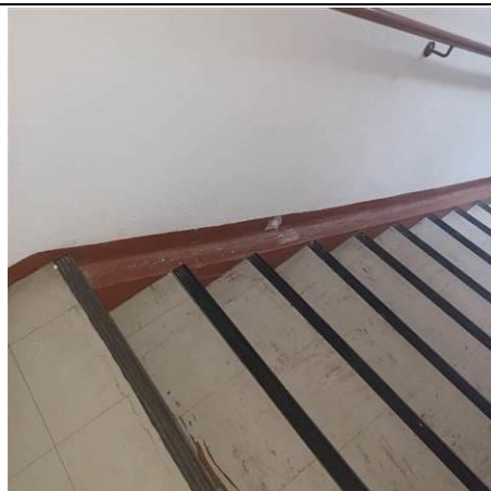
Photo n° N_A040 Localisation : ESCALIER SUD - Escalier RDC-R+1 Ouvrage : 3 - Parois verticales intérieures - Murs et cloisons maçonnés Partie d'ouvrage : Enduit à base de plâtre lissé ou taloché Description : Enduit mur béton + peinture
