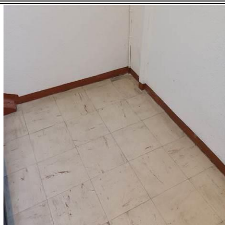
Photo n° N_A004 Localisation : ESCALIER SUD - Palier 1/2 Ouvrage : 5 - Planchers et planchers techniques - Revêtements de sols Partie d'ouvrage : Dalle de sol Description : Dalles de sol + Colle + ragréage
