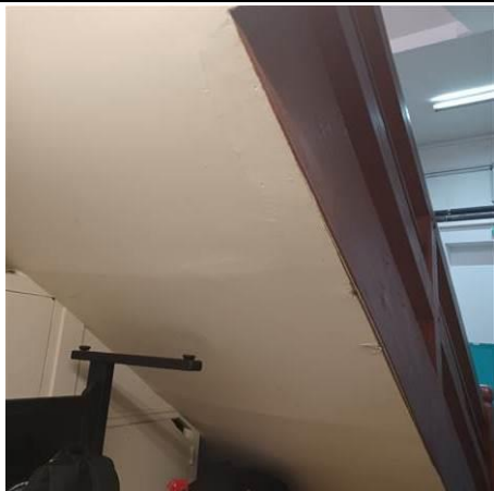
Photo n° N_A013 Localisation : ESCALIER SUD - Hall RDC Ouvrage : 4 - Plafonds et faux plafonds - Plafonds Partie d'ouvrage : Bandes calicot Description : Enduit + calicot plafond sous face
