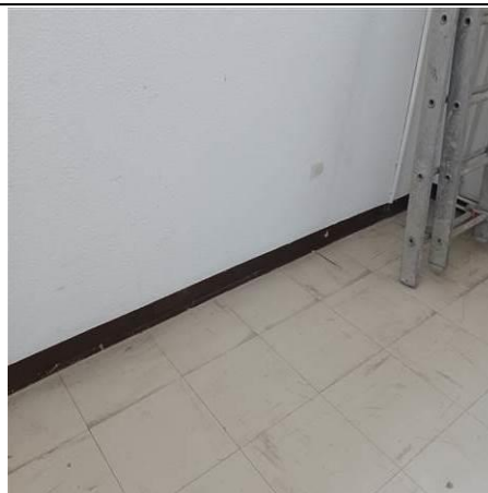
Photo n° N_A020 Localisation : ESCALIER NORD - Palier 1/2 Ouvrage : 3 - Parois verticales intérieures - Murs et cloisons maçonnées Partie d'ouvrage : Enduit à base de plâtre lissé ou taloché Description : Enduit mur béton
