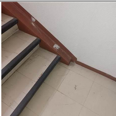
Photo n° N_A039 Localisation : ESCALIER SUD - Escalier R+1-R+2 Ouvrage : 3 - Parois verticales intérieures - Cloisons sèches (assemblées, préfabriquées) Partie d'ouvrage : Enduits à base de plâtre ou ciment projetés, lissés ou talochés Description : Enduits sur limon + peinture
